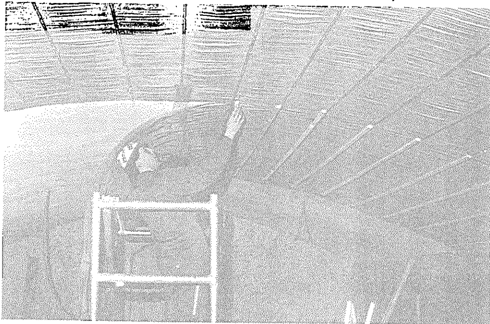
Figure 1. Les nattes en tubes capillaires se posent en sous-face du plafond. Elles peuvent être enduites d'un crépi qui pourra recevoir une finition classique (Doc. APPELSA).
